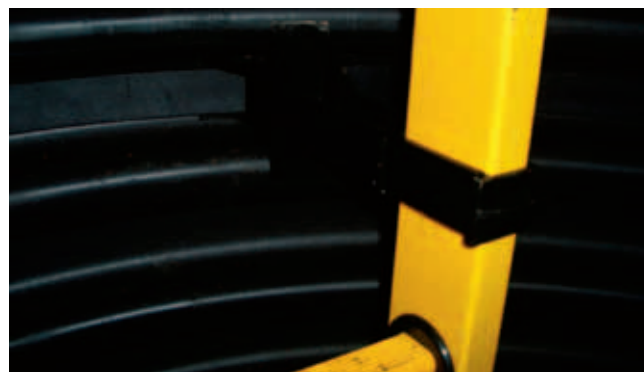
Foto 7. - Fissaggio dei supporti della staffa
