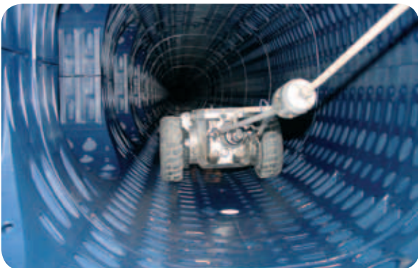
La videocamera si muove all'interno del tunnel di ispezione
